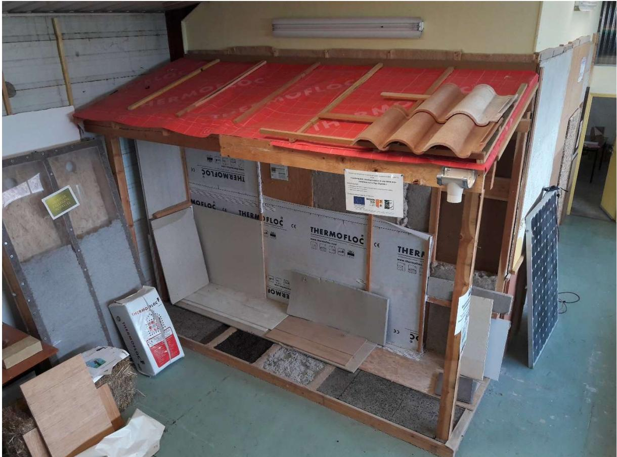
Figure 1 : Module de démonstration isolation et étanchéité à l'air
