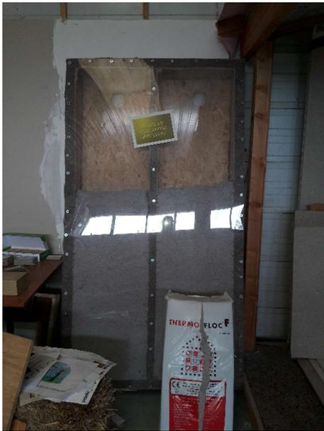
Figure 2 : Insufflation ouate de cellulose
