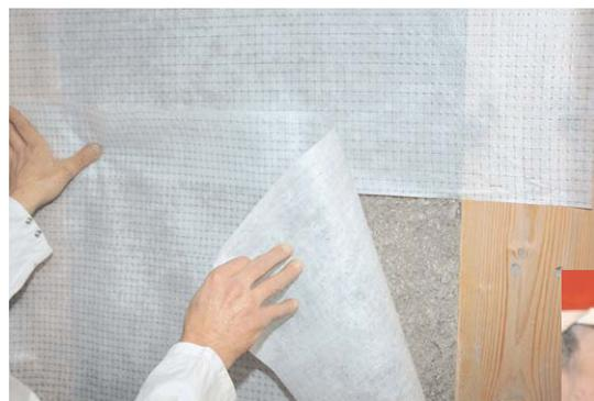
En conclusion le pare vapeur THERMOFLOC permet de garantir une grande résistance au déchirement, une adhérence importante des points de collage et le maintien d'une humidité minimale dans les systèmes constructifs y compris les moins respirants et les plus hermétiques à l'air et protège à long terme l'isolant et le système constructif.
