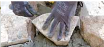
Maçonnerie de pierres
