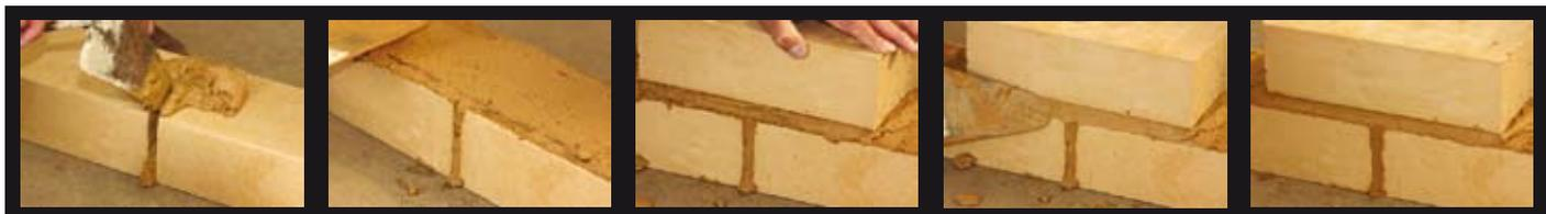
Argilus™ fournit le mortier prêt à l'emploi en sac de 25Kg, afin de coller les briques.
